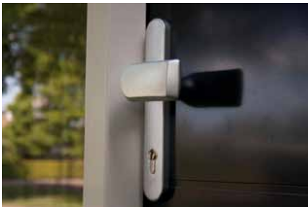
Foto: Inbraakveilig hang- en sluitwerk bij groot onderhoud
