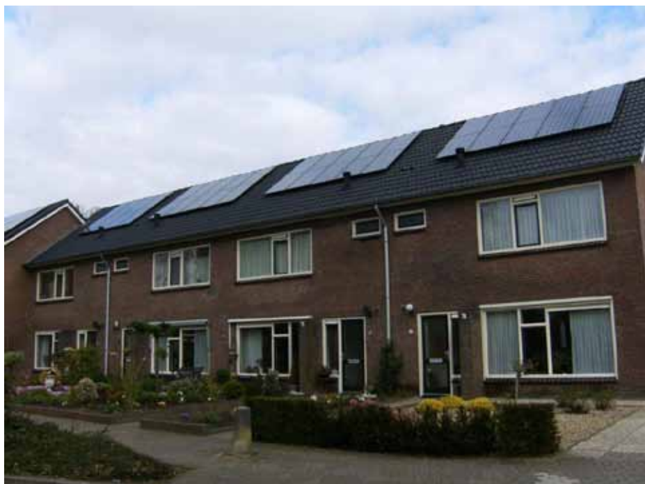
Foto: Zonnepanelen Het Lannink/Galgenmaten
