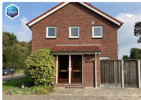
We gaan 31 woningen slopen en vervangen door nieuwe, duurzame woningen. Tot die tijd verhuren we tijdelijk leegstaande woningen via Gapph. Zo houden we de buurt leefbaar.
