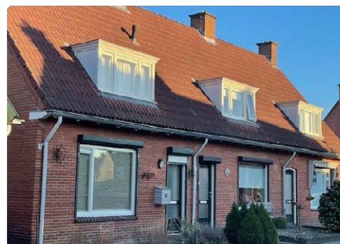
Vorbereidingen gestart voor sloop 31 woningen op 4 locaties in Delden en nieuwbouw van woningen voor kleinere huishoudens.
